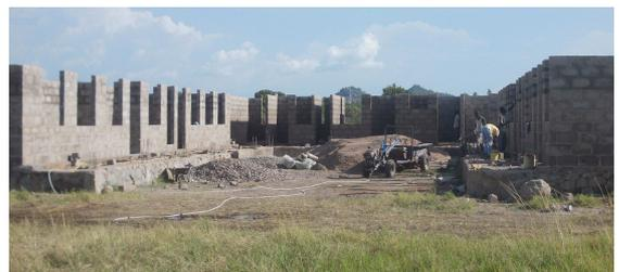
Nachdem sich das Finanzchaos nach meiner Rückkehr etwas gelichtet hatte folgte Vollendung des Fundaments, Herstellung von 7200 Zementblöcken und mittlerweile ist der Bau der Wände vollendet – bzw in der nächsten Woche folgt hoffentlich die
